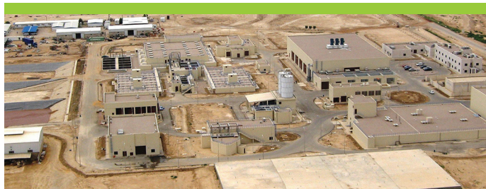
station de dessalement Wadi Main (Jordanie) - 135 000 m 3 /j
