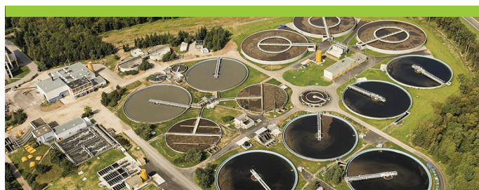
station d'épuration des eaux résiduaires urbaines Mulhouse (France) - 98 000 m 3 /j
