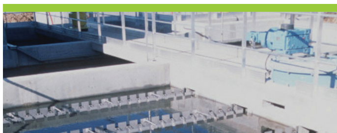
station d'épuration des eaux résiduaires urbaines Les Mureaux (France) - 20 000 m 3 /j
