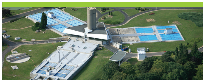
station de production d'eau potable Morsang-sur-Seine (France) - 84 960 m 3 /j
