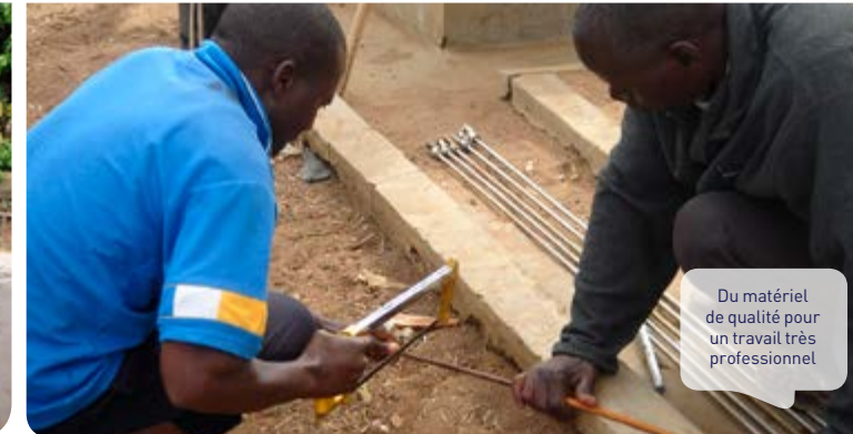
Les artisans-réparateurs locaux se forment
