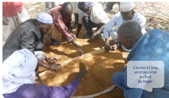
Les travaux de construction sont terminés
